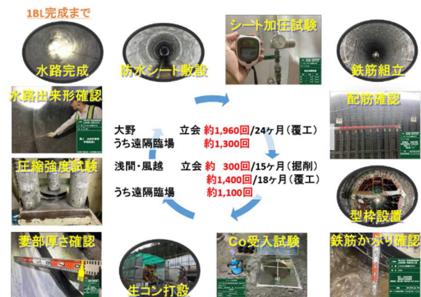
図5 覆工の施工サイクル
