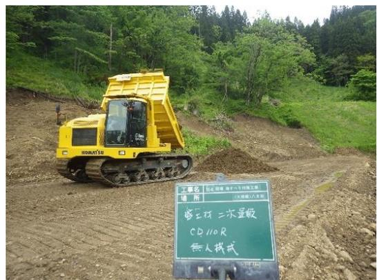
写真5 MC重機を用いた無人の土砂運搬
