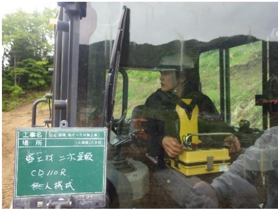
写真-6 MC重機を遠隔操縦するオペレータ
