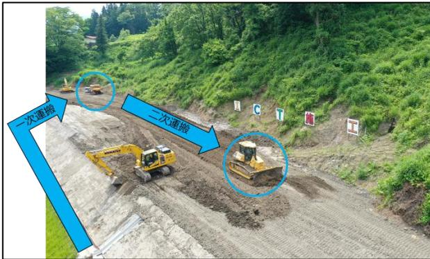
写真-7 土砂二次運搬のイメージ
