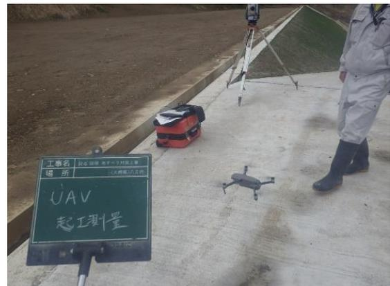
写真-3 起工測量に使用したUAV（ドローン）
