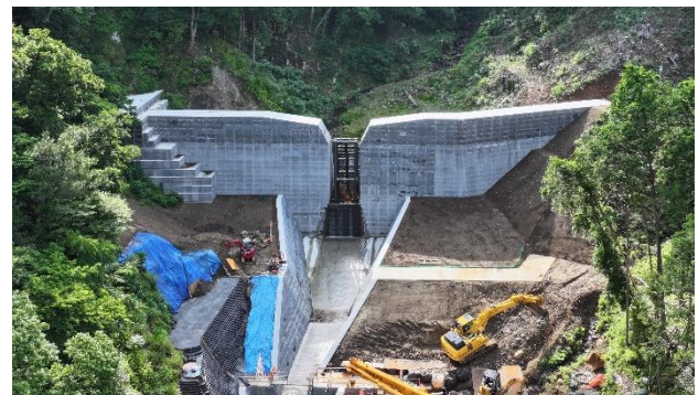
図-2 施工中の松沢川第2砂防堰堤
