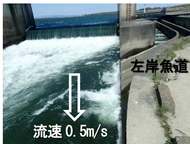
写真－5 土砂吐ゲート1号(上段)からの放流
