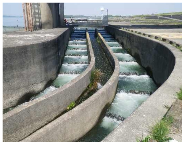
写真-2 左岸魚道
