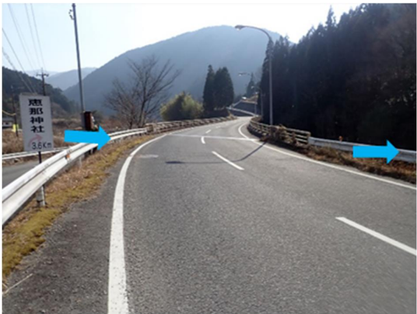
図-12 飛行経路中の道路横断箇所（国道363号）
