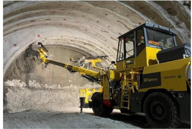
写真-4 フルオートコンピュータージャンボによる削孔状況
