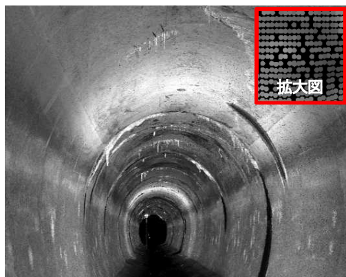
図-2 ひび割れ・湧水調査の結果（点群モデル図）
