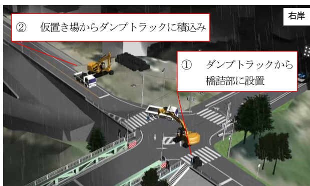
図-11 大型土のう設置訓練
