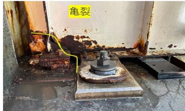
写真-3 令和6年3月緊急点検時 A1橋台桁端部
