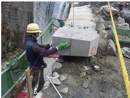
写真5 石材設置の様子
