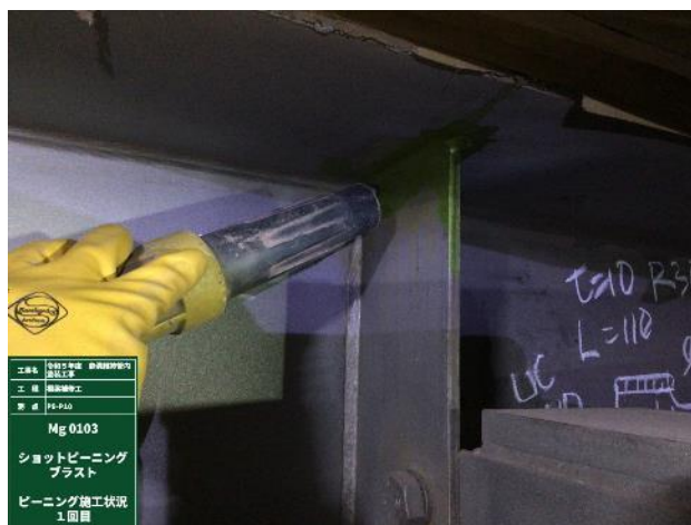
図-10 ショットピーニング施工状況
