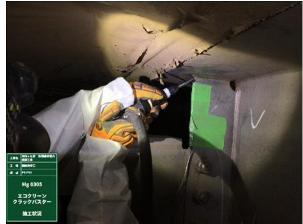
図-8 クラックバスター施工状況
