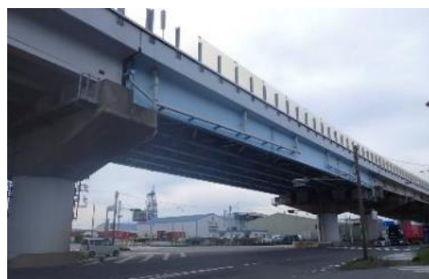
図-2 興津高架内埠頭第3橋梁外観
