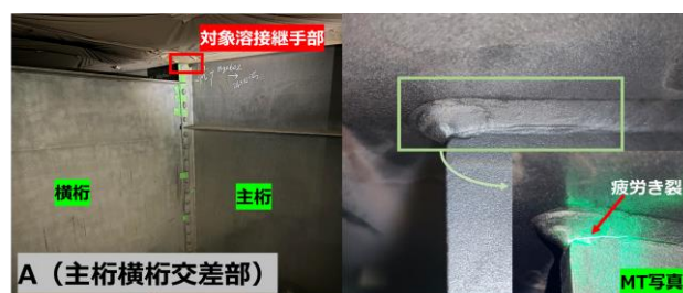
図-3(b) 主桁横桁交差部 (A)
