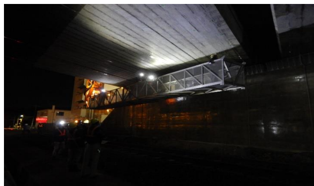
橋梁点検車（歩廊式）による補修工事の施工
