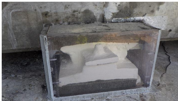
クリアプロテクト工法
