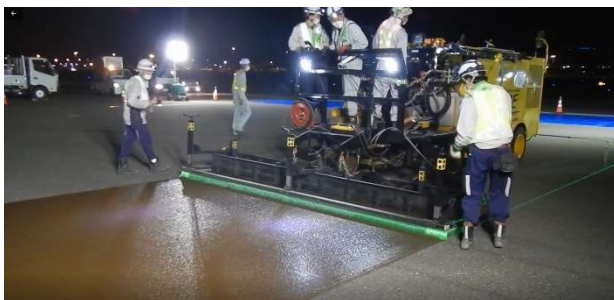
写真-3 専用施工機による塗布状況
