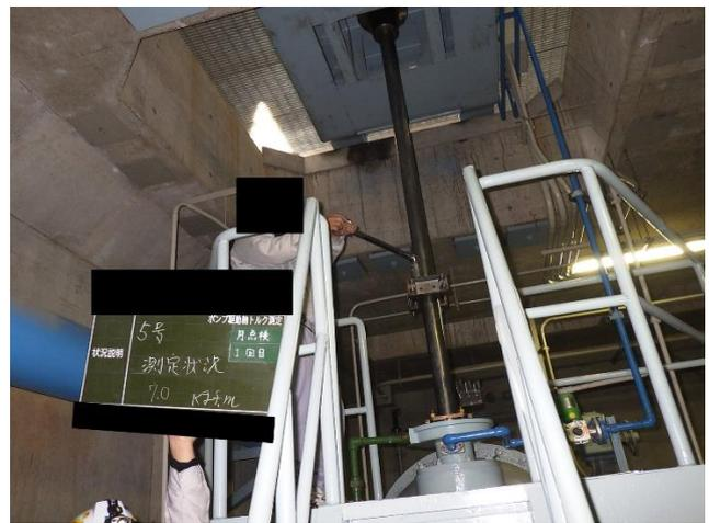
図7 トルク測定写真①
