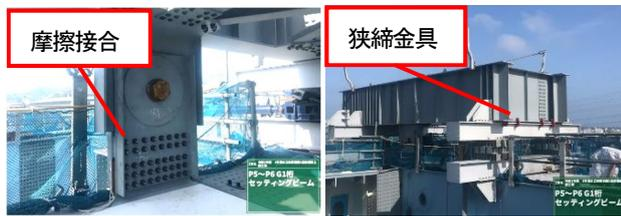
写真-3 トルシアボルトを用いた摩擦接合（左）
