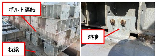
写真-1 枕梁による安定とボルトによる堅固保持（左）
