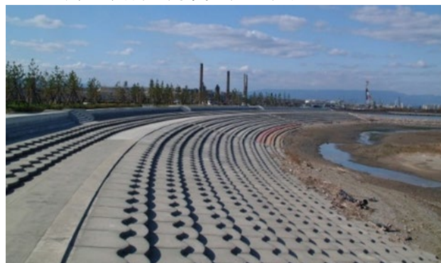
写真-1 テラス（西黒部工区）
