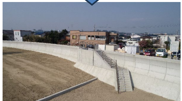
写真-7 実際に整備したスロープ （阿漕浦・御殿場工区）
