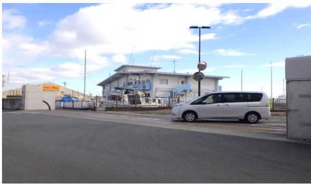
写真-8 フラップゲート式陸閘（平常時）
