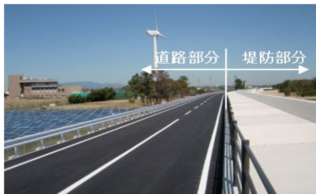
写真-5 一連施工した都市計画道路と海岸堤防
