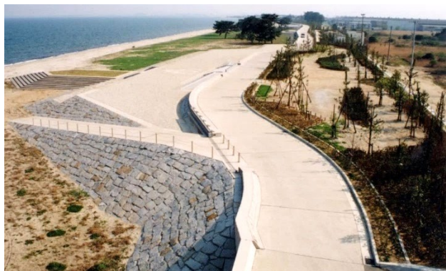
写真-4 緩傾斜護岸（香良洲地区）
