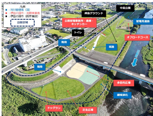
図-6 整備後の川の駅「伊豆城山」
