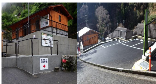
図－1 2 「うつろぎ」の公衆トイレと駐車場
