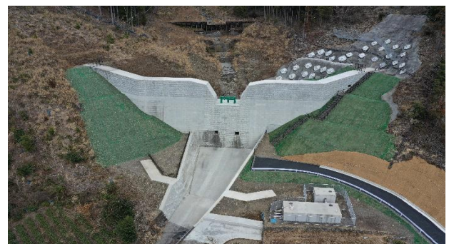
図－11 杉の木沢砂防堰堤
