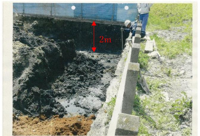
図-7 土壌が2m以上の深さで、油等の化学物質によって汚染されていた。（図-6と同じ場所）
