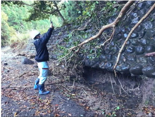
図-1 被災現場の3次元計測状況
