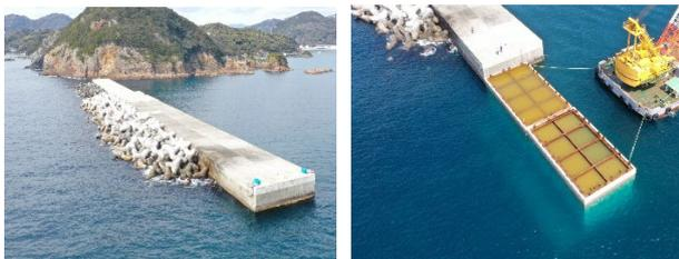
図-2 従来型ケーソン式 (左) とHBケーソン式 (右)
