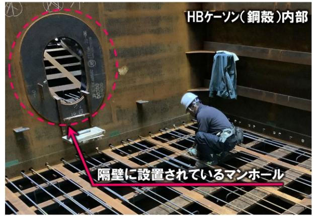
図-8 隔壁に設置されているマンホール
