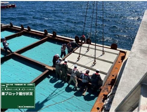
図-11 プレキャスト蓋コンクリートの設置状況
