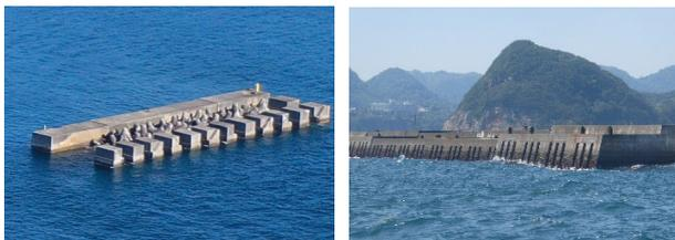
図-3 双胴型ケーソン式(左)とスリットケーソン式(右)
