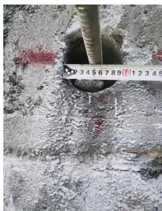
図-10 鉄筋挿入の孔径確認の様子
