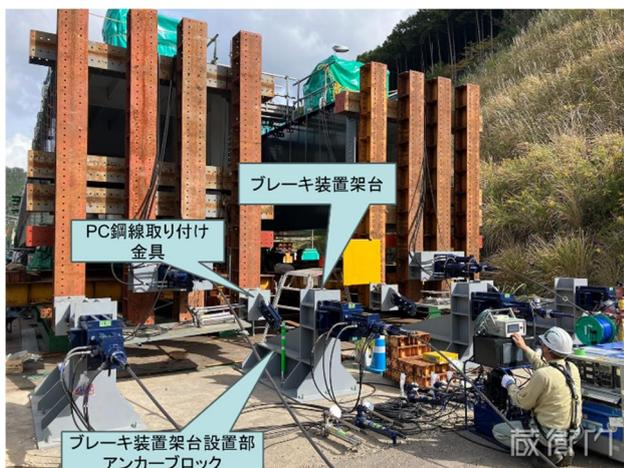
図-10 逸走防止対策（架設作業時）
