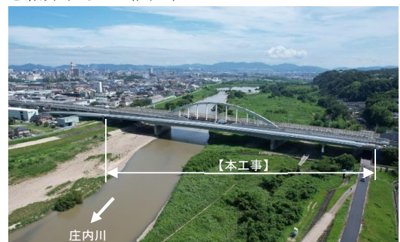
図-2 庄内川大橋
