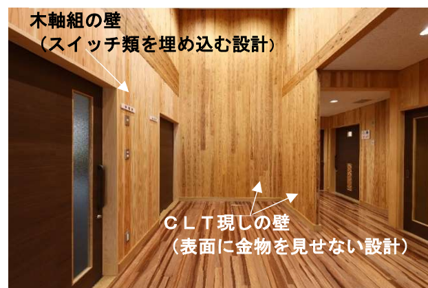
図-11 木軸壁とCLT壁の様子
