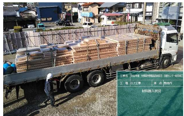
図-8 CLT現場搬入の様子
