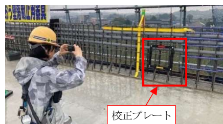
図-16 鉄筋出来形の画像撮影
