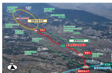
図-6 東海環状自動車道三重区間全景
