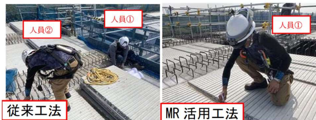
図-12 配筋マーキング方法比較
