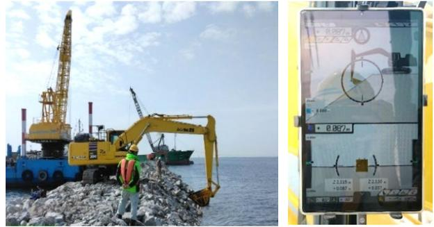
写真-5 施工状況及びシステム画面
