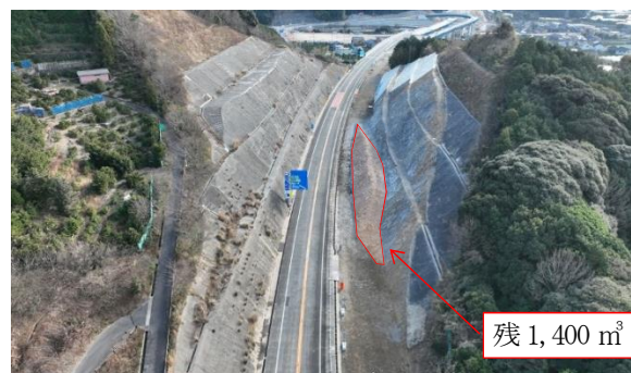
写真-3 規制解除前（名古屋側より豊橋側を望む）
