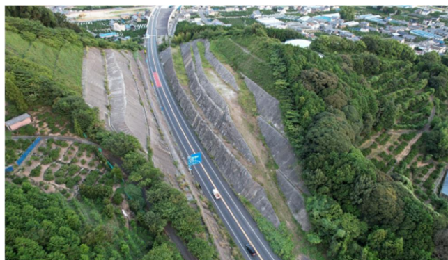
写真-1 施工箇所着手前（名古屋側より豊橋方面を望む）
