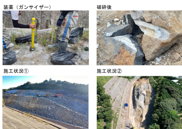
写真-2 施工状況
