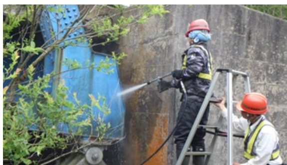
写真-2 洗浄状況
