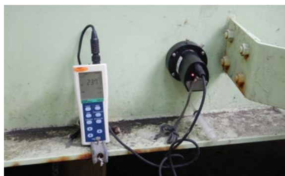
写真-3 調査状況
