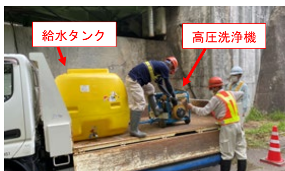
写真-1 使用機材（給水タンク、高圧洗浄機）
