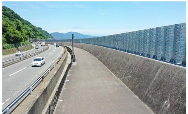
図-4 越波飛散防止柵設置状況
