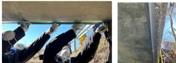
写真6 自治体職員によるDIY補修実施状況
