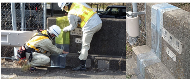
写真5 防水シリコン粘着シートによる止水
