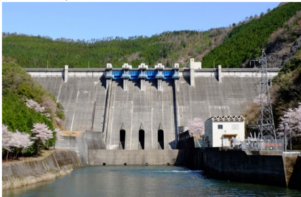
写真.1 蓮ダム堤体全景
