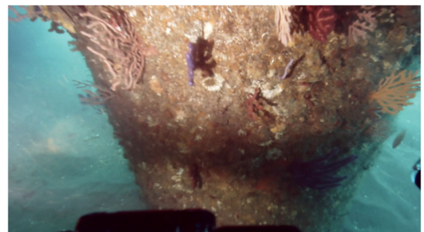
図ー1 7 鋼管杭点検の様子
