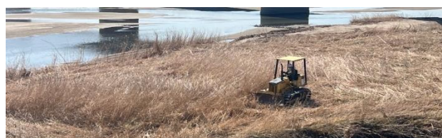
図-8 重機による踏み倒しの実施状況（矢作川）
