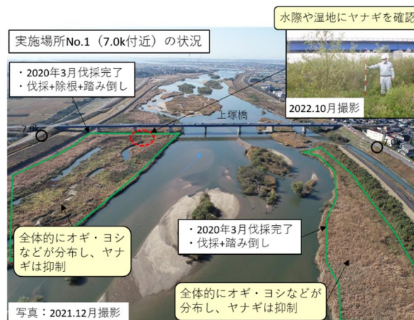
図-10 踏み倒し後の状況（実施場所No.1）（矢作川）
