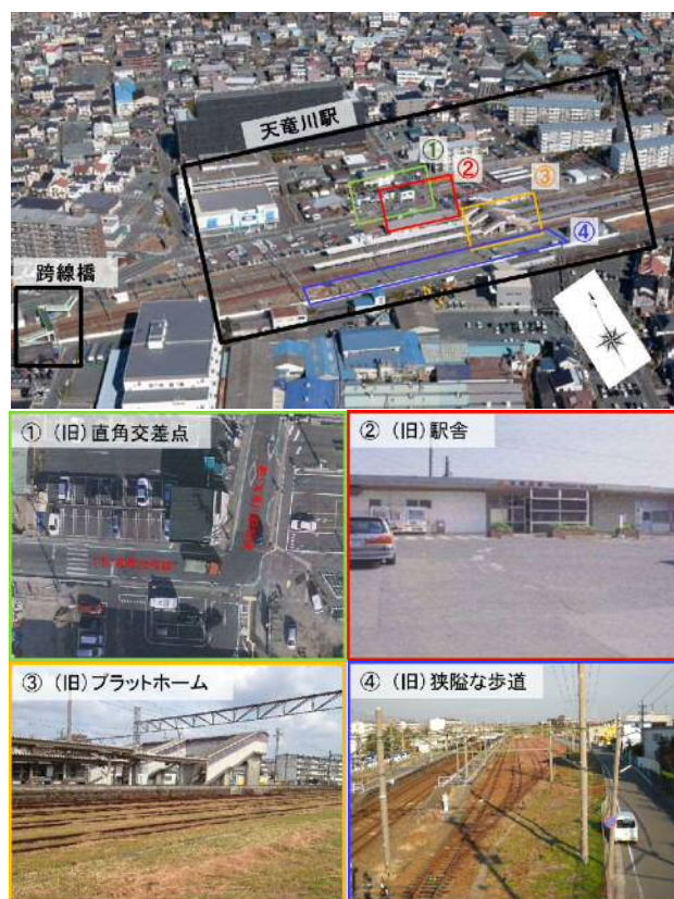
図—2 整備前の天竜川駅
