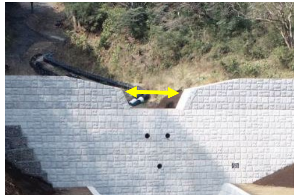
図-2 砂防堰堤の水通し幅（矢印）
