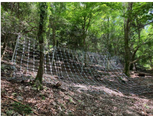
写真-3 完成写真
