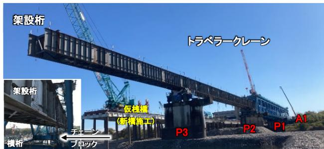
図-18 車道桁撤去
