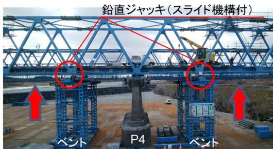
図-8 鉛直ジャッキによるジャッキアップ
