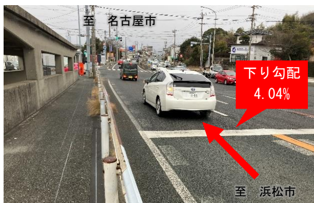
図-15 国道1号 岩屋下交差点における道路環境
