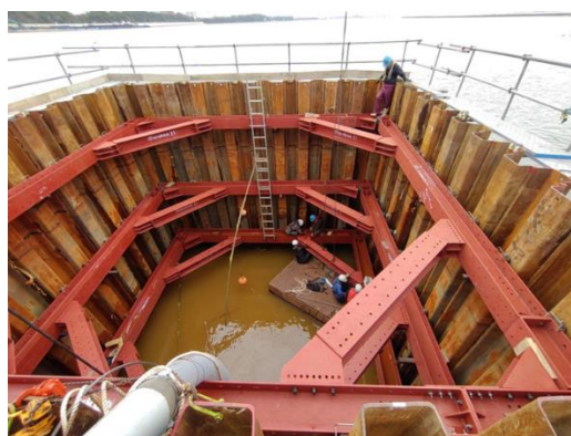
図-10 不発弾B撤去に伴う矢板
