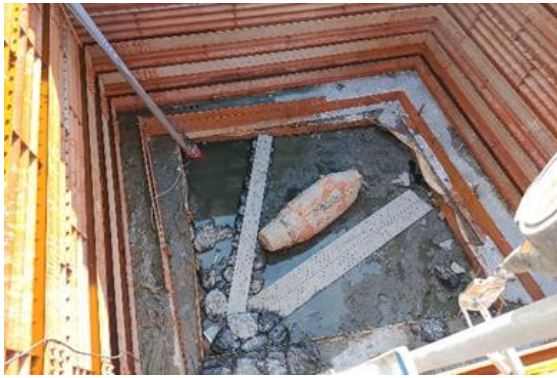
図-15 防護施設内に露出させた不発弾A
