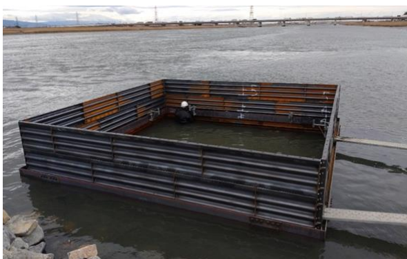
図-7 不発弾Aの撤去に伴うライナープレート（変更前）
