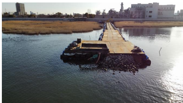
図-8 不発弾Aの撤去に伴う工事用仮設道路
