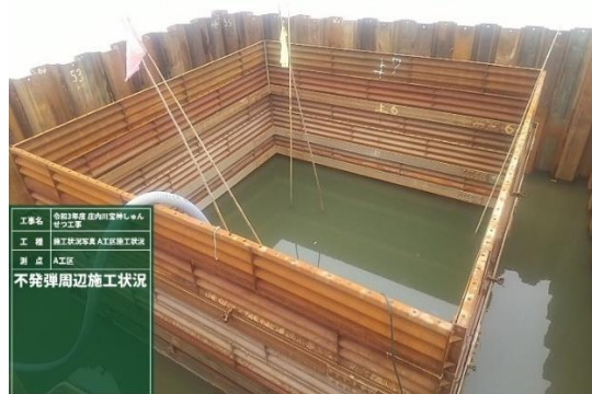
図-11 不発弾A撤去に伴う矢板・ライナープレート構造
