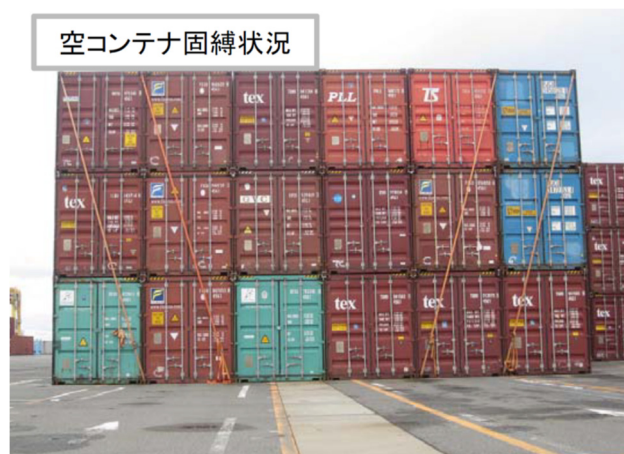
図-7 空コンテナ固縛による事前対策 12)
