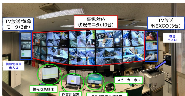
図-3 高規格道路管理センターにおける情報収集の状況
