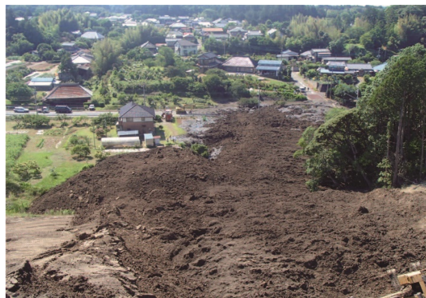
図 1-2：広島県 廃棄された土石の崩落
