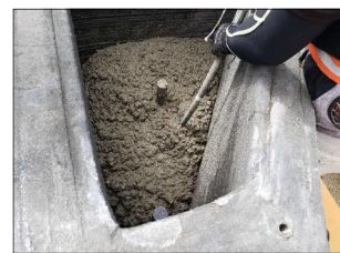
図-6 コンクリート打設状況
