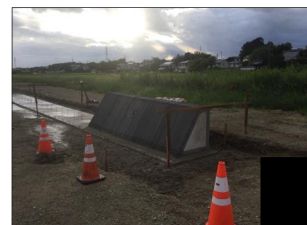
図-7 重力式擁壁の据付状況
