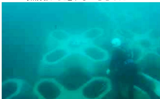
図-10 水中ドローンで撮影した水中施工状況
