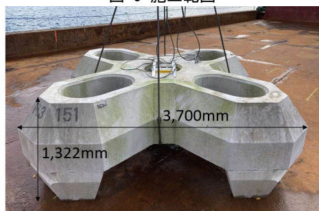
図-4 被覆ブロックの寸法
