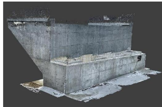
図-8-1 橋梁下部工の取得データ
