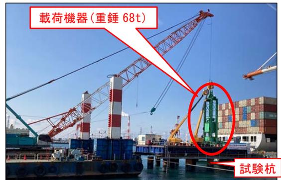
写真-2 急速載荷試験の実施状況
