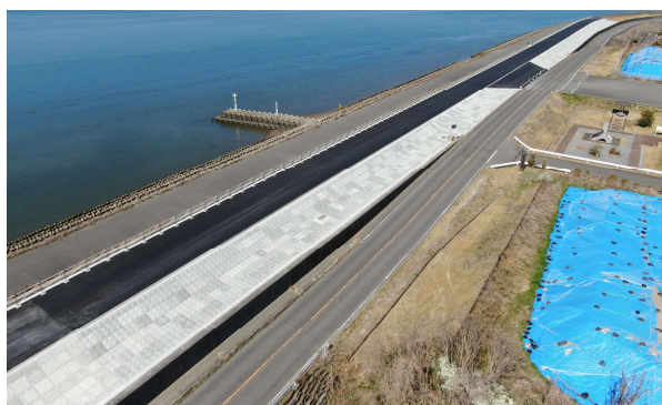
図-3 施工後の外観
