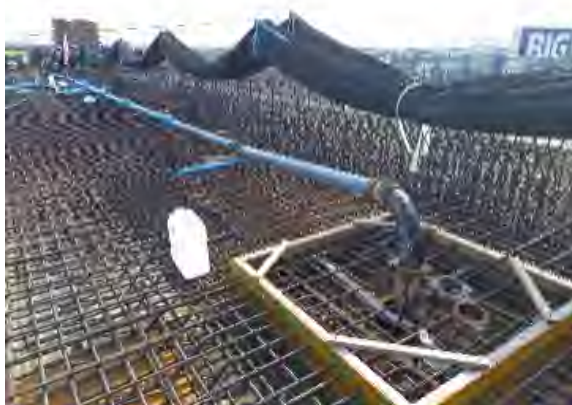
図-8 コンクリート打設口(上)と 打設口からの配管(下)
