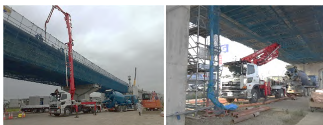
図-6 通常の圧送打設(左)と桁下からの圧送打設(右)
