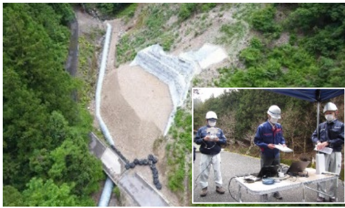
図-13 UAVリアルタイム配信（百々之木谷第1砂防堰堤）
