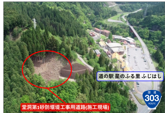
図-11 遠隔臨場実証実験(堂洞第1砂防堰堤)
